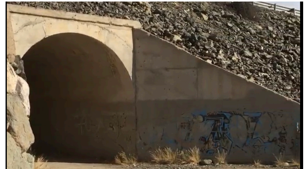
Moottoritien alittava tunneli. Sen kautta pääsee turvallisesti vuoriston puolelle.
