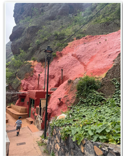
Silmiinpistävä ratkaisu, betonoitu ja maalattu julkisivu
